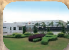
中台廣州塑膠機組裝廠
